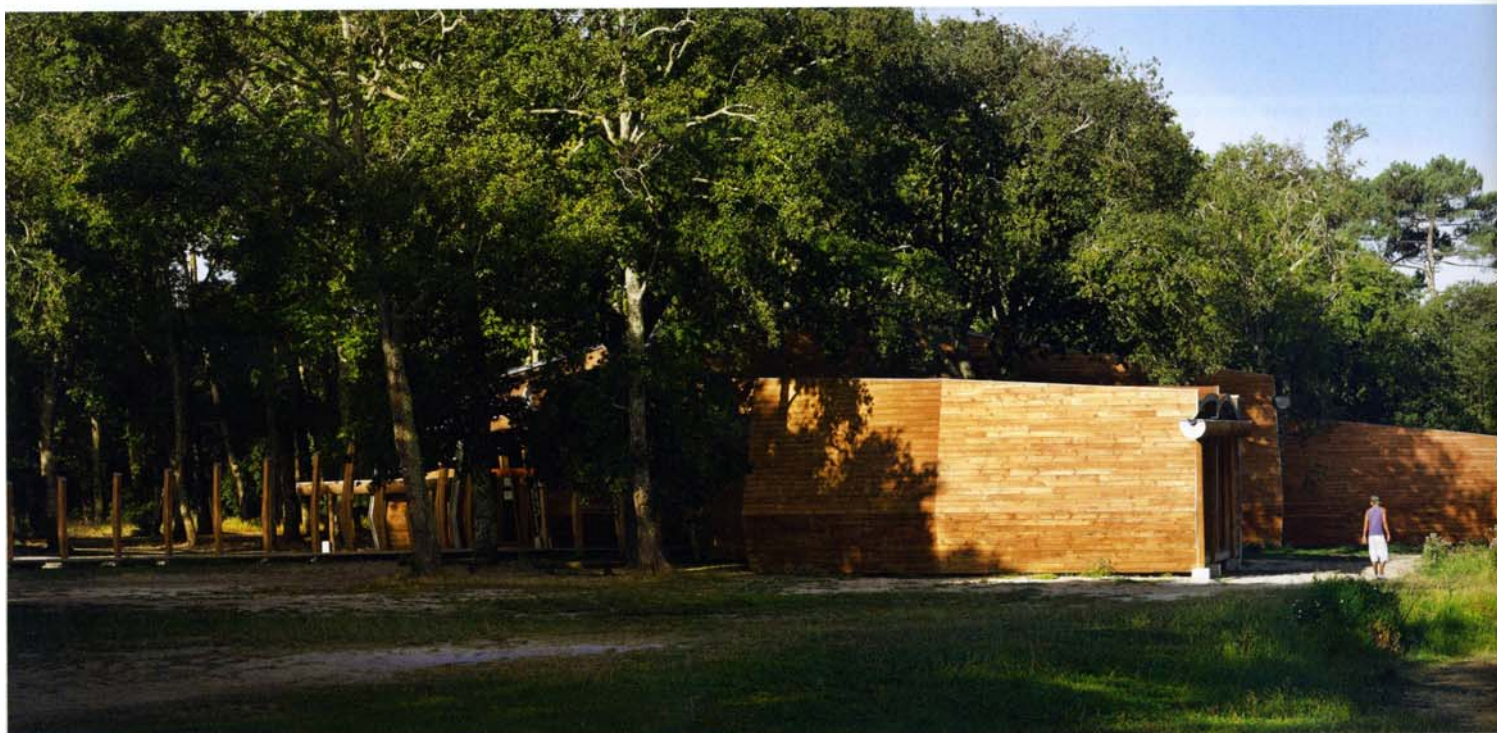
L'implantation dans le sous-bois de chênes, pins et aulnes, contribue à un rafraîchissement économe en été.
